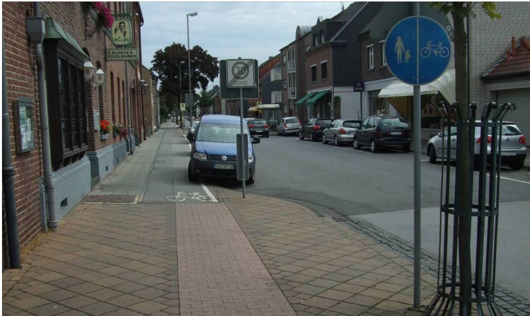
Abb. 37: Beispiel Hauptstraße – Unklarer Übergang und mangelnde Breite im Zweirichtungsverkehr (Quelle: Eigenes Foto)
