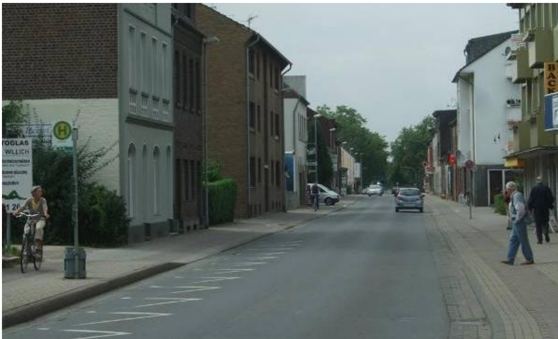
Abb. 46: Heutige Situation Bahnstraße, Höhe Moltkestraße/Krusestraße (Quelle: Eigenes Foto)
