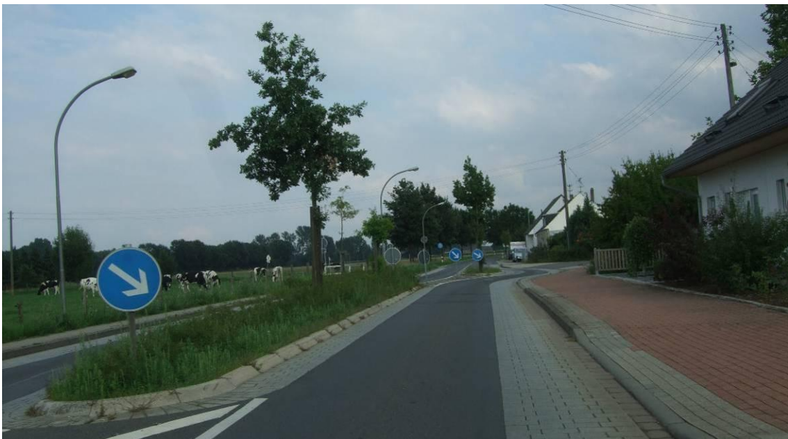
Abb. 53: Optische Einengung der Fahrbahn durch Pflasterung der Seitenbereiche in Vennheide (Quelle: Eigenes Foto)
