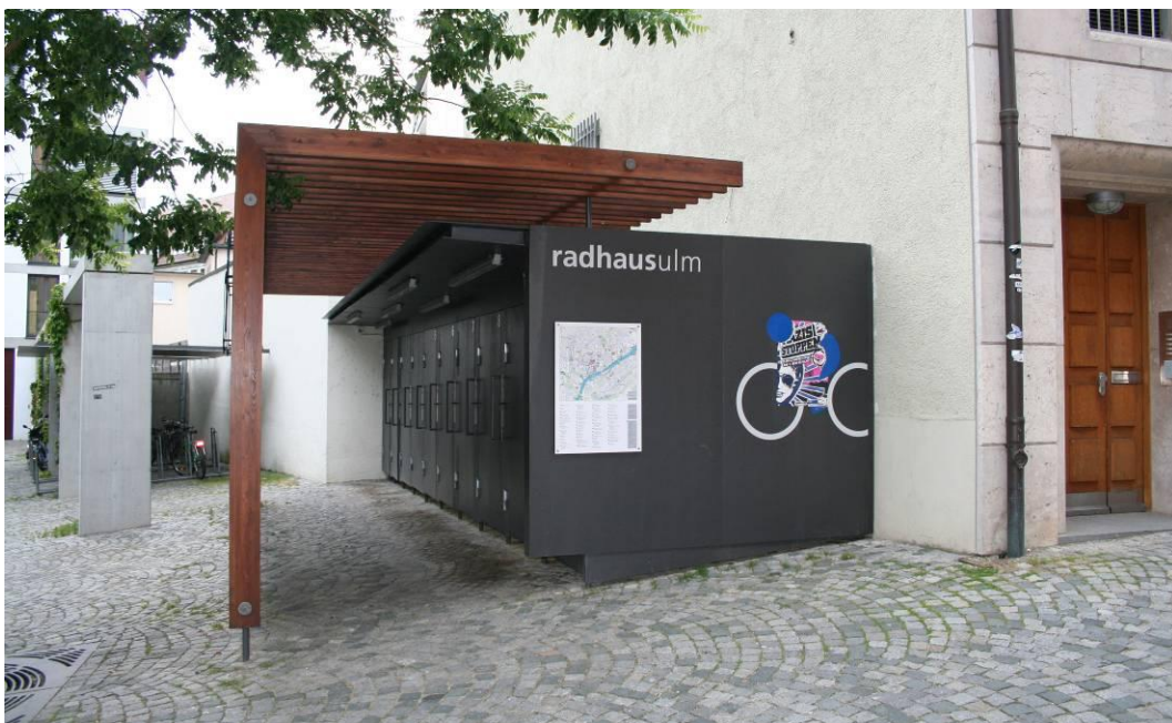
Abb. 89: Beispiel für eine Anker-Radabstellanlage (Quelle: Eigenes Foto)
