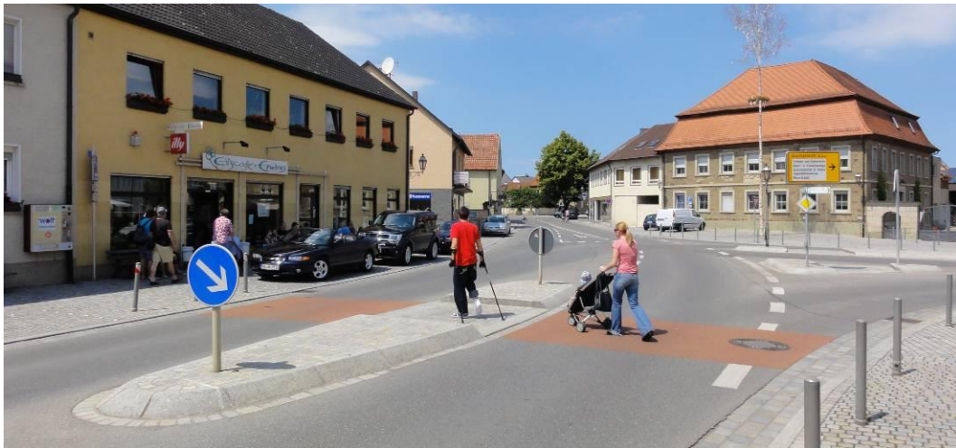
Abb. 93: Einfärbung/Markierung Asphalt an einer Querungshilfe (Quelle: Eigenes Foto)
