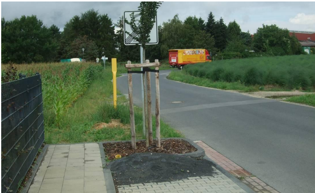
Abb. 102: Fortführung des bereits begonnenen Gehwegs an der Ulmenstraße (Quelle: Eigenes Foto)
