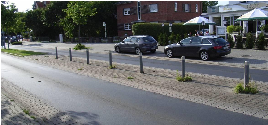
Abb. 49: Lineares Querungsband direkt westlich des Kreisverkehrs Parkstraße (Quelle: Eigenes Foto)
